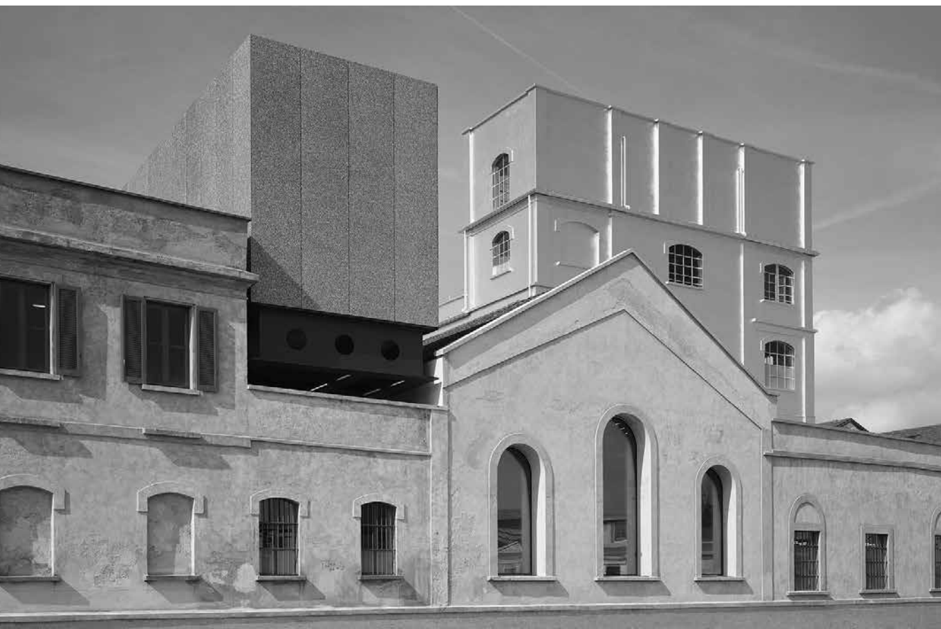
• Obnovljena stara tovarna z novimi stavbami | © Bas Princen, Fondazione Prada
