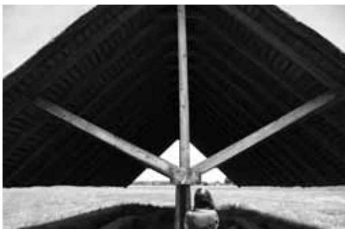
• Oton Jugovec, osrednji nosilni detajl strešne konstrukcije | foto: Ana Skobe
