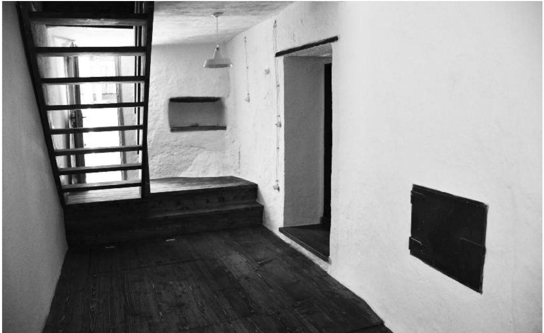
: Veža po opravljenih sanacijskih in restavratorskih posegih | foto: Andrejka Ščukovt, 2021
