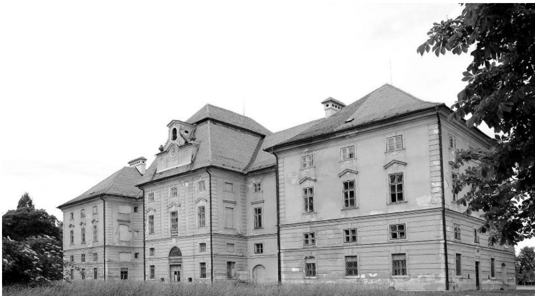
: Južna fasada dvorca Novo Celje | foto: Arhiv ZAG
