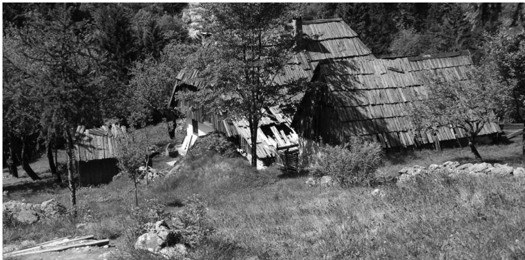
: Stanje stavb na Turarjevi domačiji pred pričetkom obnove | foto: Andrejka Ščukovt, 2018
