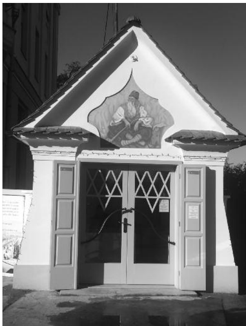
: Trafika po obnovi, 2019 | vir: dokumentacija ZVKDS OE Maribor
