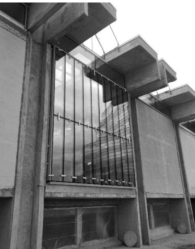
: Vzhodna fasada nekdanje tiskarniške hale (Tiskarna Mladinska knjiga) v času prenove, po namestitvi zasteklitve na posamezne segmente fasade, rekonstrukciji svetlobnikov in odstranitvi sekundarnih oblog (toplotne izolacije) s konstrukcije, ki prodre na fasado. Sledi sanacija vidnih betonov in namestitvev fasadne obloge. | foto: Tina Potočnik
