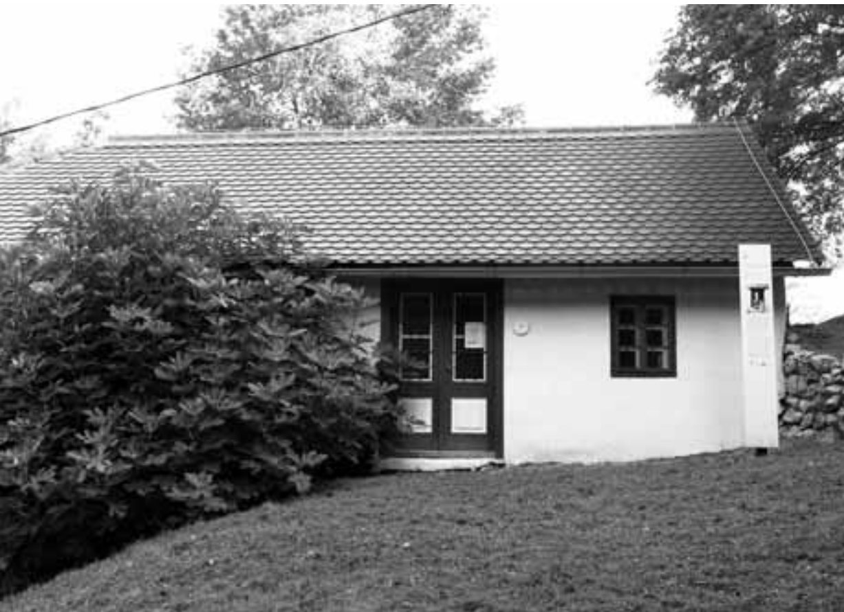
• Almina hiša na Pečovniku, stanje po obnovitvenih delih | foto: Matija Plevnik, september 2018
