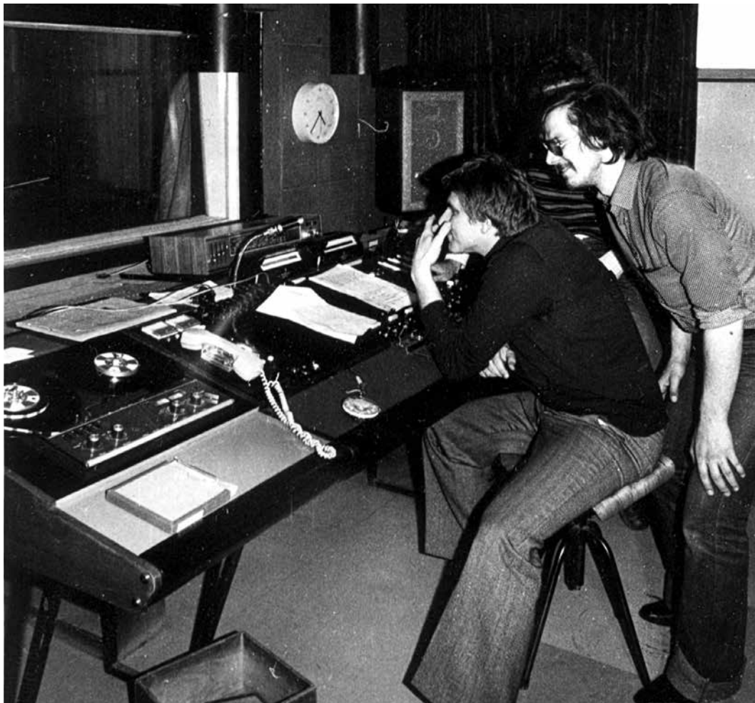
• Iskrina mešalna miza, ki sta jo zasnovala in izdelala t. i. Iskrin Elektro-akustični laboratorij in Radio Študent | foto: arhiv Radia študent
